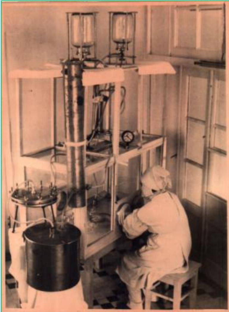
Рабочий момент во время заготовки стерильного водного раствора мочевины. Стерилизация раствора производится с помощью фильтра Сальникова, фильтрование - через индивидуальный шелк-капронный фильтр, а разлив во флаконы - в настольном боксе.
